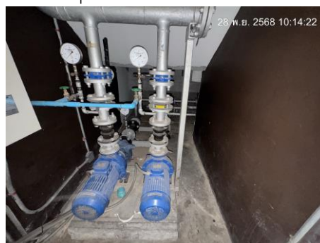
ถังเก็บน้ำสำรอง ใต้ดิน และ Transfer Pump อาคาร A
