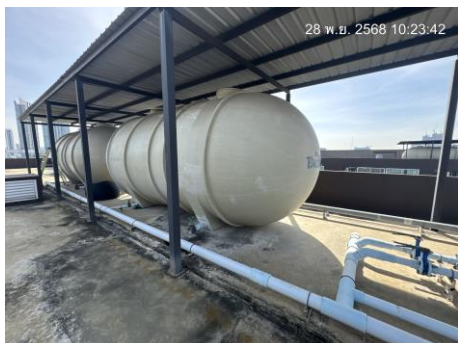
ถังเก็บน้ำสำรองดาดฟ้า และ Booster Pump อาคาร B
