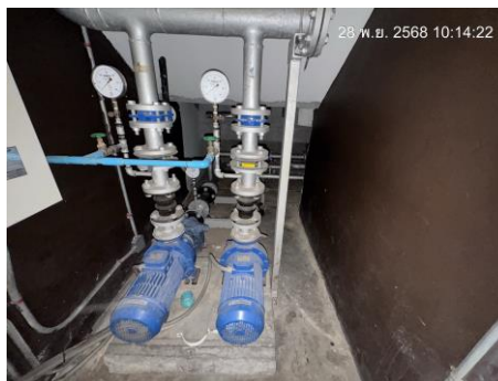
ปั๊มระบบบำบัดน้ำเสียอาคาร A
