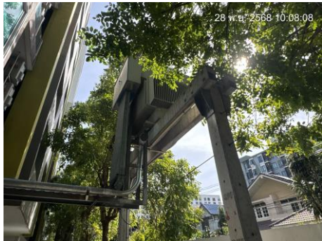
หม้อแปลงไฟฟ้าโครงการ อาคาร A
