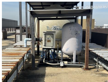
ถังเก็บน้ำสำรองดาดฟ้า และ Booster Pump อาคาร A
