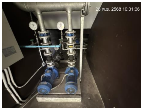
ปั๊มระบบบำบัดน้ำเสียอาคาร B
