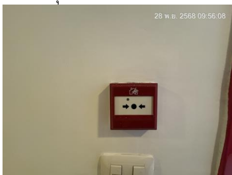
อุปกรณ์แจ้งเหตุด้วยมือ รูปที่ 2.1-13 ระบบป้องกันอัคคีภัย
