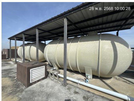
ถังเก็บน้ำสำรองดาดฟ้า และ Booster Pump อาคาร A
